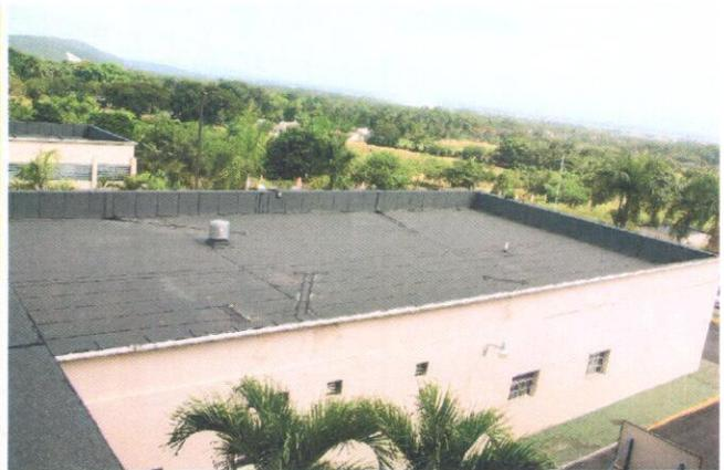
Con la impermeabilización se busca detener las filtraciones de agua, que afectan varias áreas de la infraestructura. Estas producen plagas de insectos, hongos y el peligro de fallas en la estructura.
